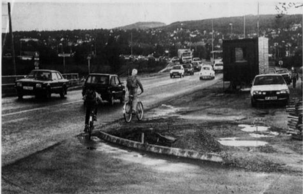
Anleggsområdet i krysset rv 44/Gauselvågen skaper farlige situasjoner for mange trafikanter.
