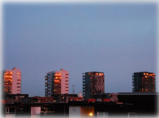
Det bygges tett og høyt i Jåttåvågen.....
