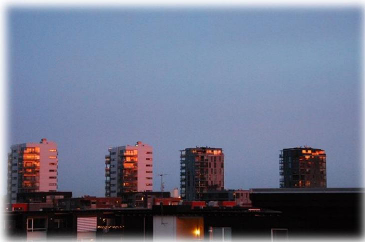
Det bygges tett og høyt i Jåttåvågen.....
